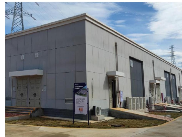
国网时代宁德霞浦储能电站数字孪生项目 （200MW/400MWh）
